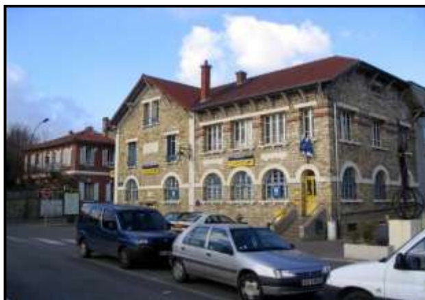
Le bureau de poste avant les travaux
