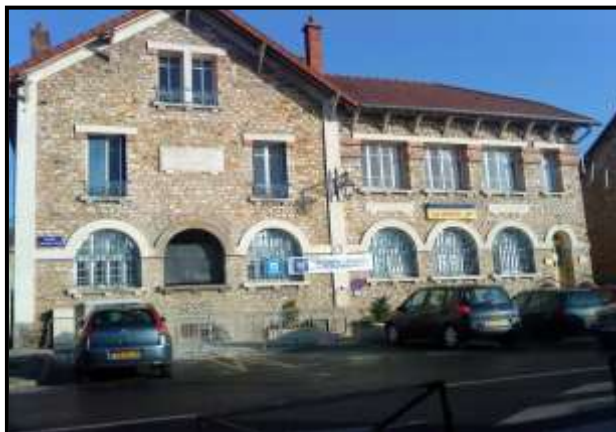
Le bureau de poste pendant les travaux
